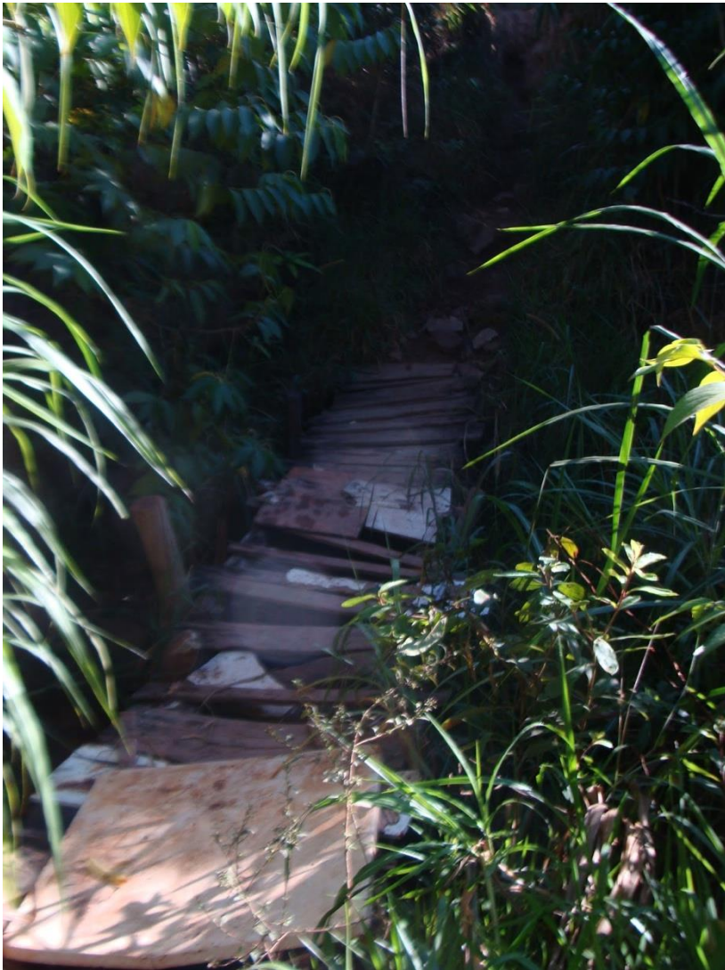
Ponte antes da Ação
