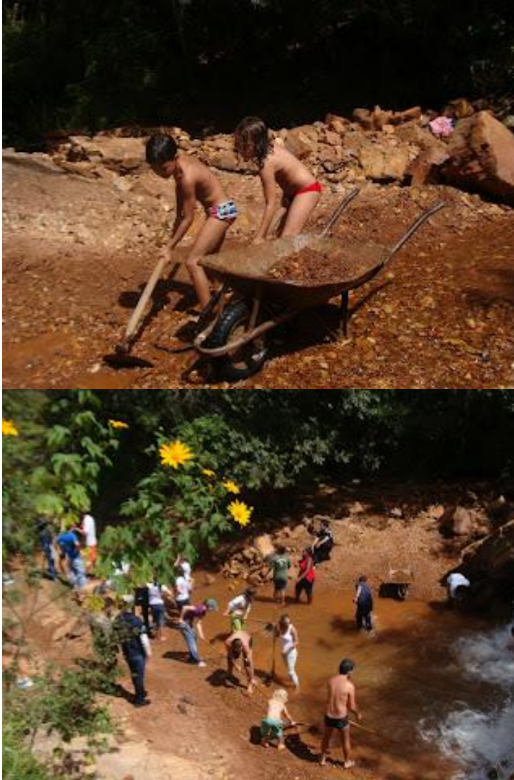
Ação comunitária para desentupir o poço da cachoeira do Córrego Urubu e reconstituir os barrancos do córrego, assoreados e danificados pelas águas superficiais e falta de infiltração após a implantação do Setor Taquari, sem infraestrutura verde.
